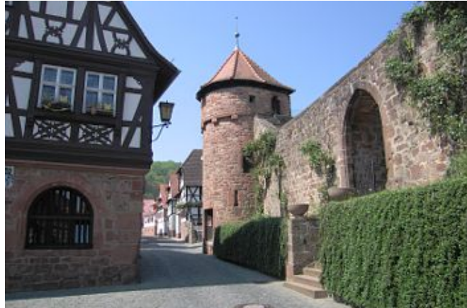
Fachwerkhäuser an der Dörrenbacher Wehrkirche
